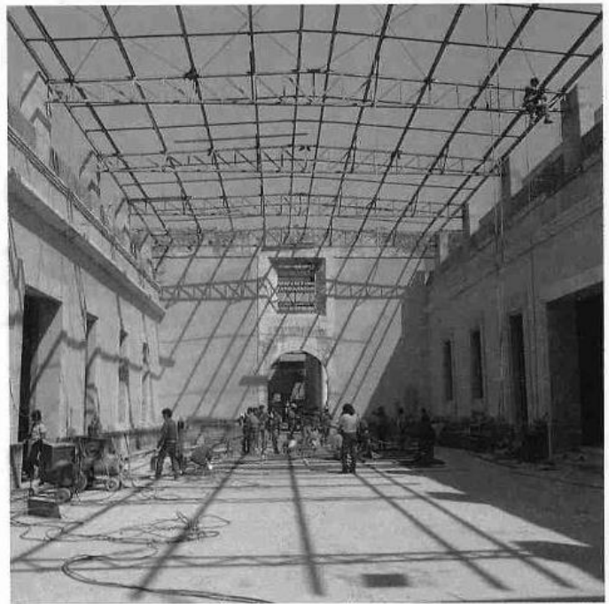
Colocación de estructura metálica en el asoleadero sur.
