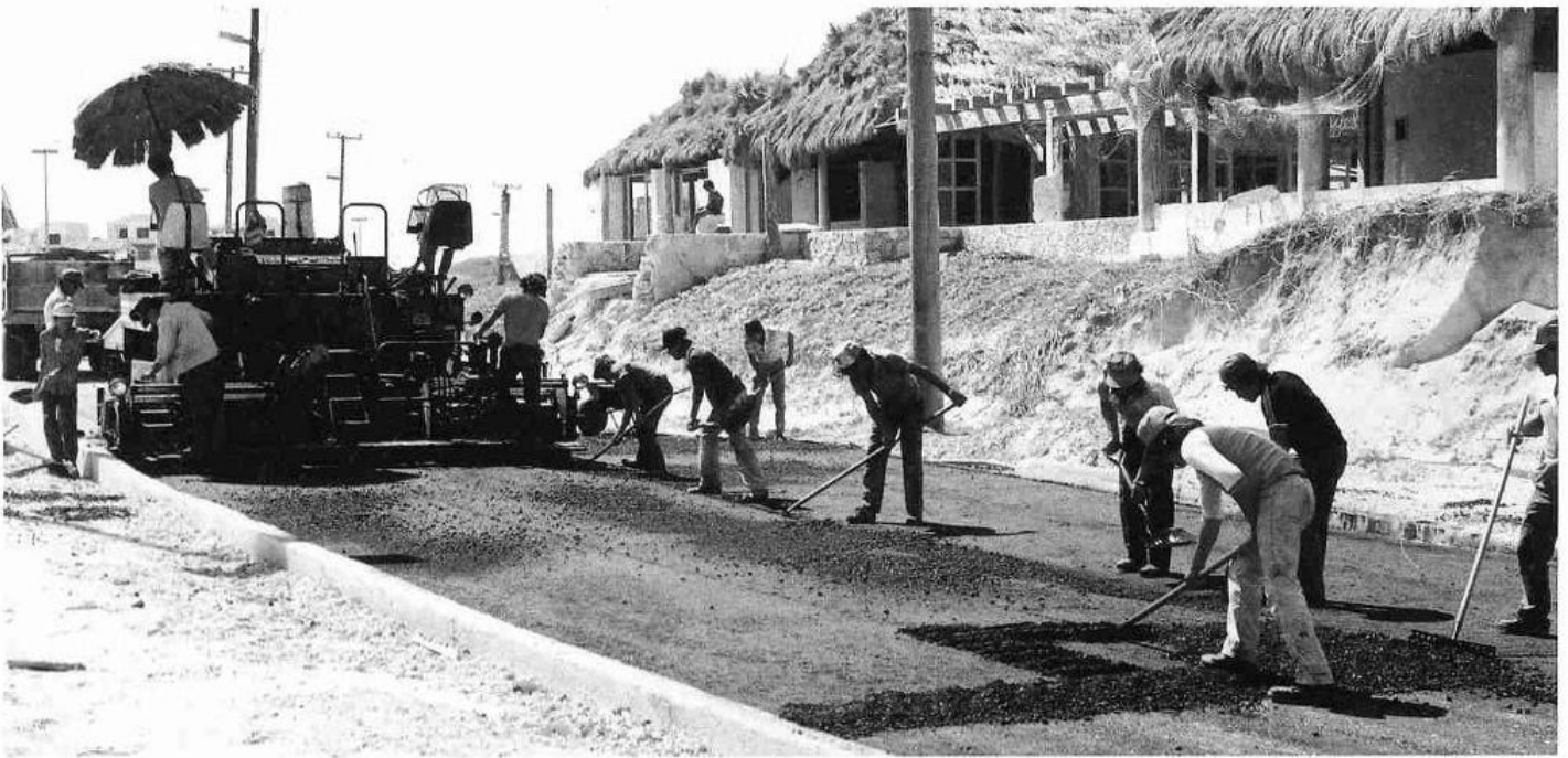
Trabajos de pavimentación del Boulevard Kukulcán en Cancún.
